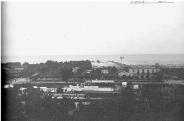
12 de Enero de 1922- Union de dos fotos, donde se puede apreciar la construccion de la escollera y la nula profundidad que existia en el lugar. Eso lo demuestra el perro sentado en el agua, del detalle de esta foto mostrada debajo. Se nota tambien la cantidad de arenisca dura que debio sacar la draga para llegar a la profundidad actual.
