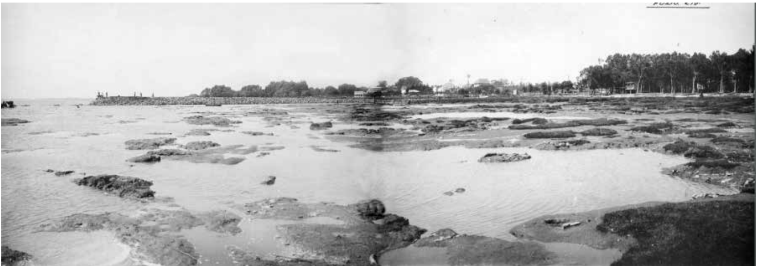
12 de Enero de 1922- Union de dos fotos, donde se puede apreciar la construccion de la escollera y la nula profundidad que existia en el lugar. Eso lo demuestra el perro sentado en el agua, del detalle de esta foto mostrada debajo. Se nota tambien la cantidad de arenisca dura que debio sacar la draga para llegar a la profundidad actual.
