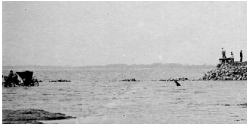
12 de Enero de 1922- Union de dos fotos, donde se puede apreciar la construccion de la escollera y la nula profundidad que existia en el lugar. Eso lo demuestra el perro sentado en el agua, del detalle de esta foto mostrada debajo. Se nota tambien la cantidad de arenisca dura que debio sacar la draga para llegar a la profundidad actual.
