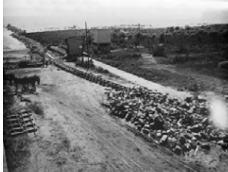
12-1-1922 Vias Decauville montadas para llevar las piedras de la escollera
